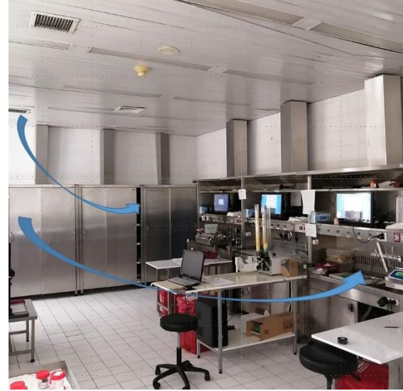
Şekil 3. Makroskopi Odası Hava Akış Yönü. Taze havanın akış yönü çevreden kabin içine doğru. Çalışan, taze hava ve numune arasında konumlanmaktadır. Fotoğraf: Patoloji laboratuvarı makroskopi ünitesi.
