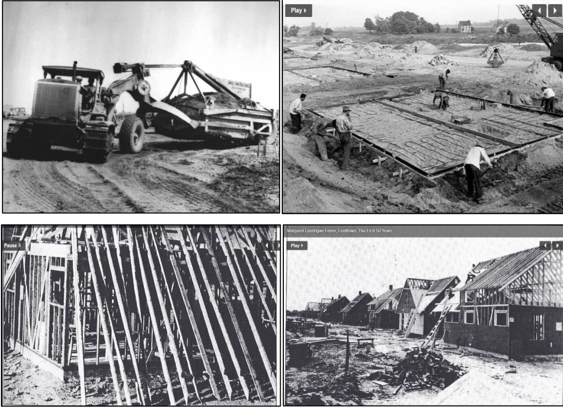
Şekil 9: Levittown Banliyösu'nde Konutların İnşası
