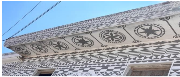
Şekil 6. Pyrgi Köyü Bina Çıkıntılarında Dairesel Sembolik Motifler (Yazar, 2023)
