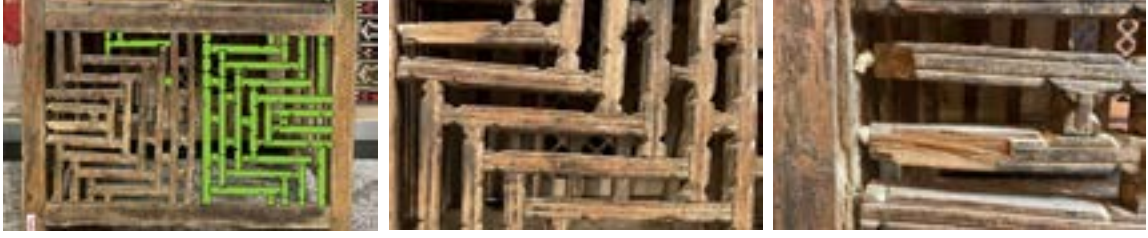
Resim 4. Şeyh Bahşi Mescidi Vaaz Kürsüsü, gövde ön kısmı parça kaybı örnekleri.
