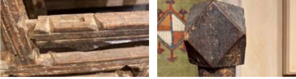
Resim 19. Şeyh Bahşi Mescidi vaaz kürsüsü zivana-kiniş kısımları yüzeyel toz ve kir birikinti örnekleri.
