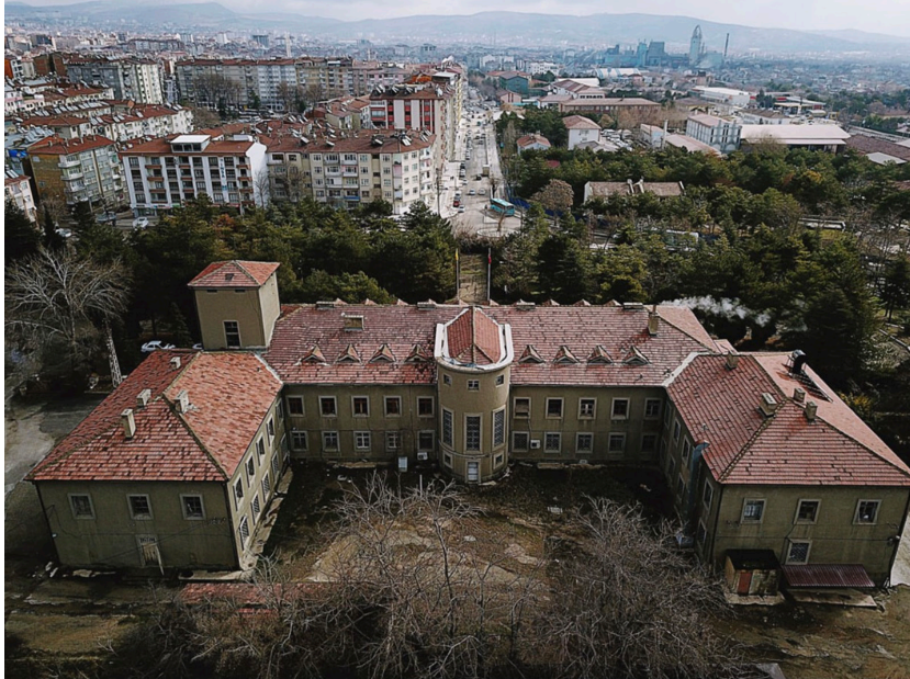
Görsel 13. Bina çevresinde bulunan açık alanlar ve yapılaşma, 2023
