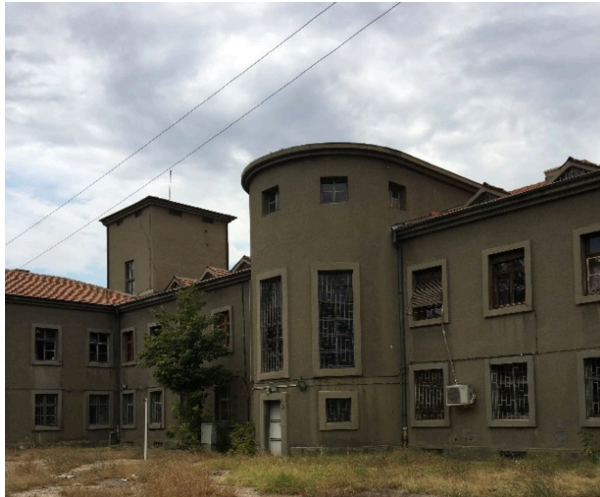
Görsel 6. Bina Arka Cephesi, 2023
