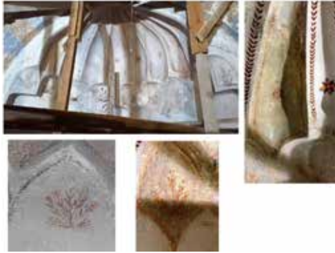
Görsel 41: Dilimli tromp yüzeylerindeki kalemişi tezyinatın görünümü (Yazar, 2023)
