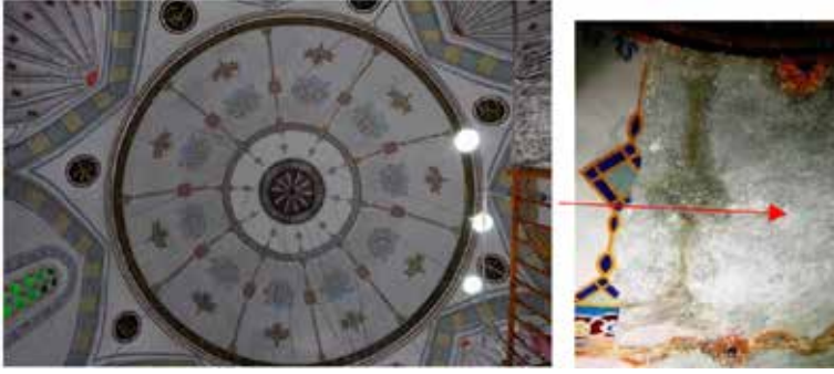
Görsel 19-20: Solda, Kubbede baklava dilimi geometrik bezemenin 1993 yılı restorasyonu sonrası görünümü 51 , sağda mekanik raspa ile açığa çıkarılan baklava dilimi geometrik desenin görünümü (Gönül Akdeniz, 2023).
