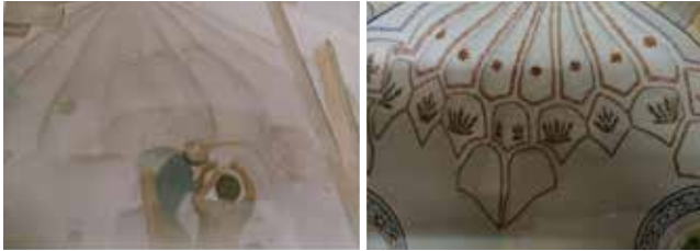
Görsel 15-16: Solda 1993 yılında Tromp yüzeyinde yapılan inceleme, sağda restorasyon sonrası tromp kalemişi süslemenin görünümü (B. V.G.M. Arşivi) 50
