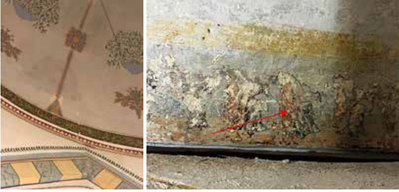
Görsel 33-34: Solda, Kubbe kasnağında 1993 yılı restorasyonunda yapılan yazı kuşağı, sağda ise yazı kuşağının altından çıkarılan Lale motifleri.
