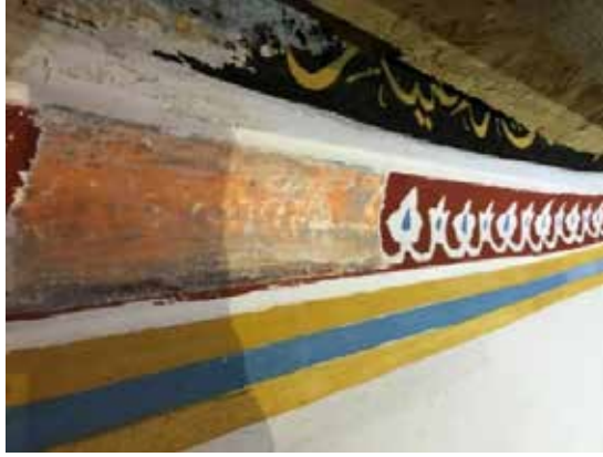
Görsel 36: Kasnak yazı kuşağının alt kısmındaki iç bükey alanın raspa sonrası görünümü (Yazar, 2023).
