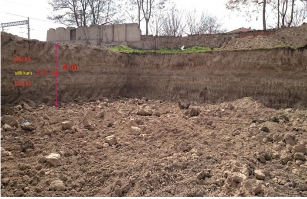
Şekil 18. Şarhöyük Mahallesi Adaçal Sokak
