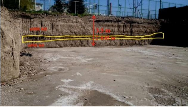
Şekil 13. Yenibağlar Mahallesi Erözlü Sokak Temel Kazısından Bir Görünüm.
