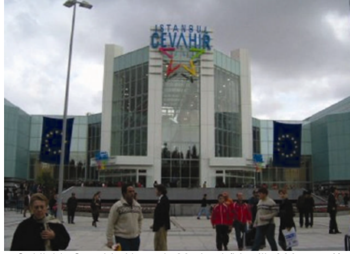
Şekil 11. Cevahir Alışveriş Merkezi (Verdil, 2007, s.76)
