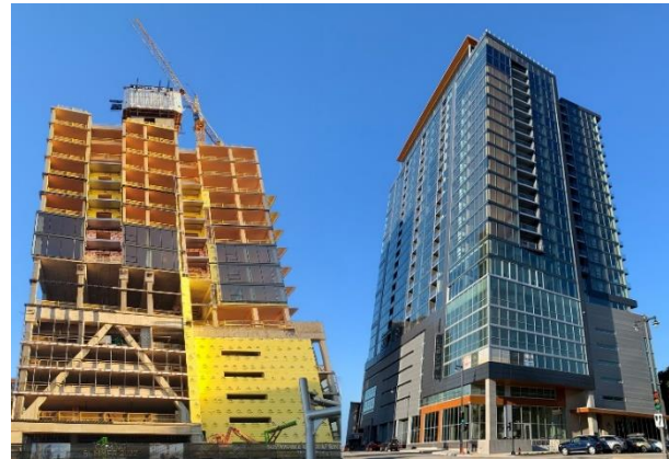
Şekil 12. Ascent Binası İnşaatı [12]
