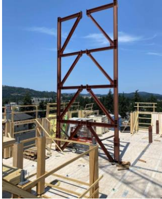
Şekil 15. Tallwood 1 Çelik iskelet ve Ahşap Kolon [15]
