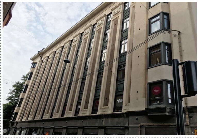
Tampere İslam Mahallesi Binası 41
