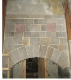
Foto. 3: Kadıhafızogulları Evi (T. Sağlam)
