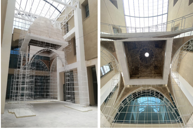
Fot. 10: a. Süleyman Han Külliyesi özgün alçı kubbesi çelik strüktüre montajı, b. Sunumu
