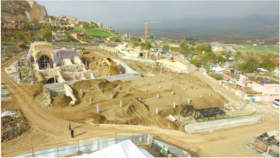
Fot. 12: Süleyman Han Külliyesi betonarme kabuk imalatını taşıyacak koruyucu duvar ve kolonların inşası ve eş zamanlı koruma dolgu uygulamaları (KVMGM arşivi)
