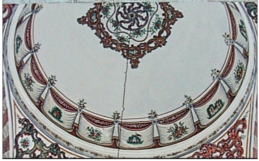
Fot. 7- Manisa Sultan Camii (İ.Kuyulu Ersoy)
