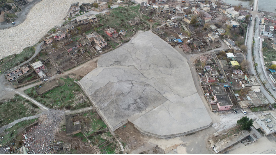
Fot. 15: Süleyman Han Külliyesi ve Koç Cami medrese kompleksinin betonarme koruma kabuğu (Sevgi ve Yılmaz, 2022,188)
