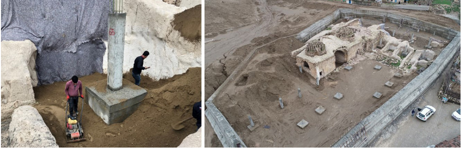
Fot. 13: Süleyman Han Külliyesi üzerine yapılan betonarme kabuğu taşıyacak kolonlar ve eş zamanlı mil dolgulama uygulaması (KVMGM arşivi; Sevgi ve Yılmaz, 2022,188)
