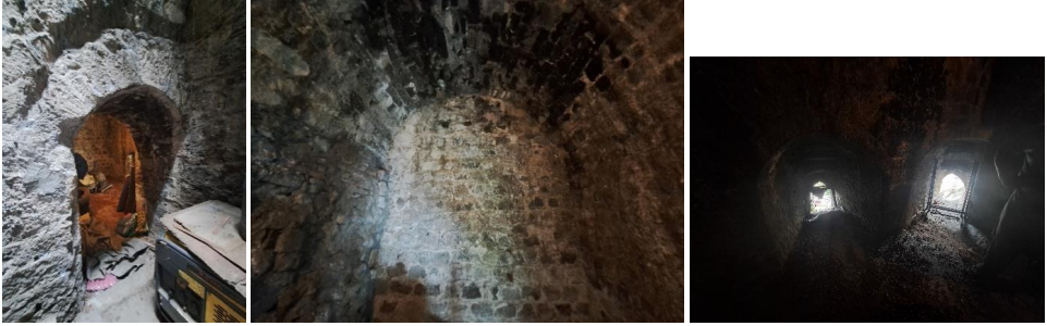
Res. 20/21/22: Kanuni Suru-Tonozlu Mekan: Kapı-İç Mekan-Lumbar Delikleri
