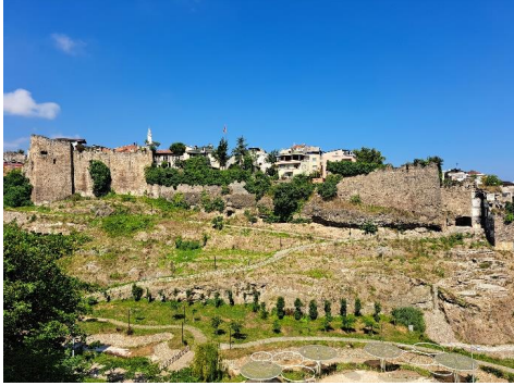
Res. 3: Trabzon İç Kale, Doğu Görünüşü (2023)
