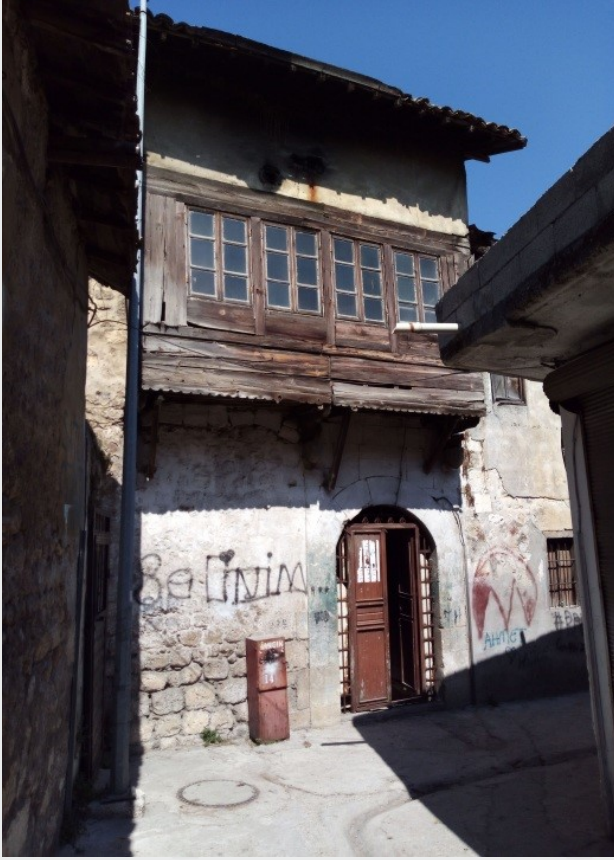
Görsel 20. Sokullu Sokağa Bakan Doğu Cephe
