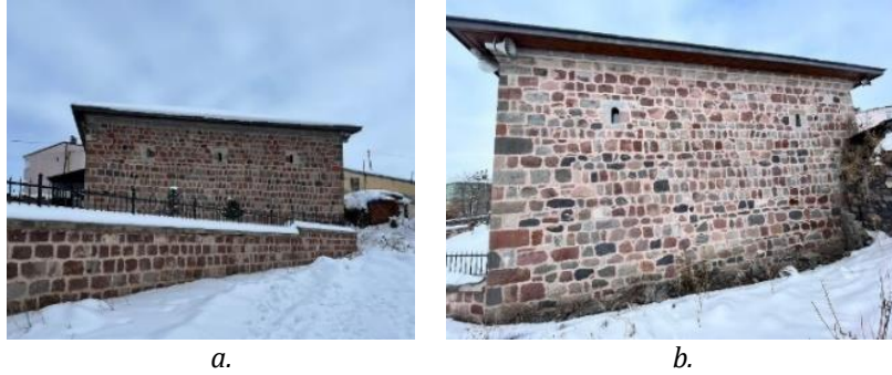
Şekil 13. Müderris İbrahim Efendi Camii batı cephesi (a), güney cephesi (b)
