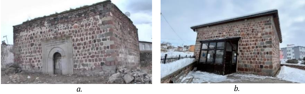
Şekil 12. Ardahan Müderris İbrahim Efendi Camii kuzey cephesi restorasyon öncesi (a)[30], restorasyon sonrası (b)
