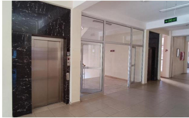
Şekil 9. MDBF binası asansörleri Figure 9. MDBF building's elevators
