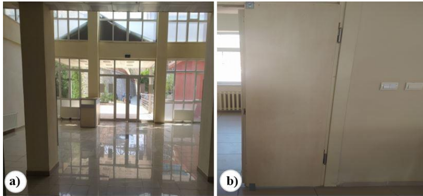
Şekil 2. MDBF binası acil çıkış kapıları a) çıkış kapısı, b) sınıf kapısı
