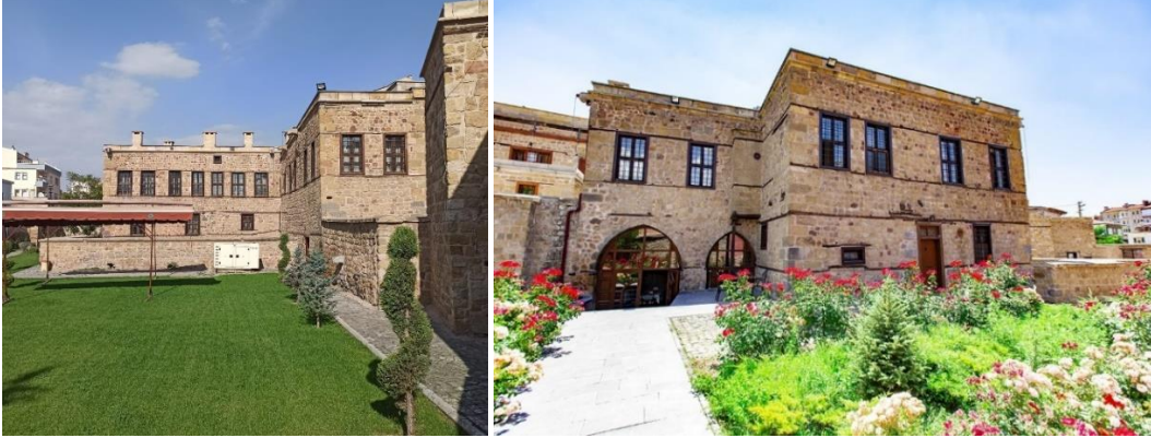
Restorasyon çalışmaları sonrası sağda güney cephe-bahçe (Efe Yavaşcan, 2023), sağda batı cephesi-bahçe (URL-1, 2016).
