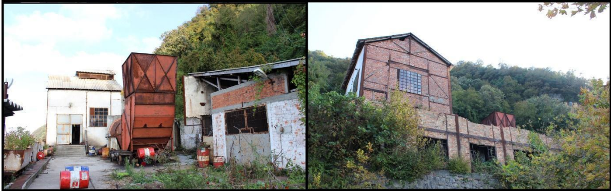
Görsel 1. Elektrik Santrali
