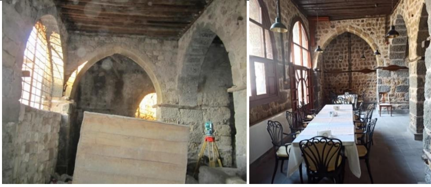
Solda restorasyon çalışmaları öncesi zemin kat (Niğde Müze Müdürlüğü, 2012), sağda restorasyon çalışmaları sonrası zemin kattaki servis mekanlarının yemek bölümüne dönüşümü (Efe Yavaşcan, 2023).
