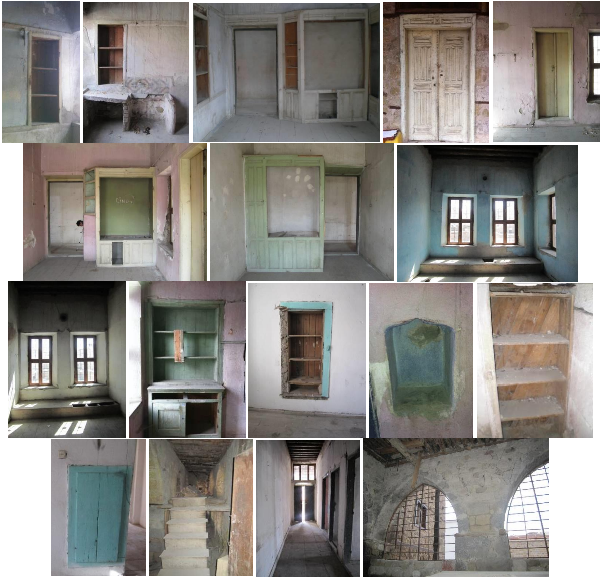
Şekil 13. Göncü Konağı Mimari Elemanları (Niğde Göncü Konağı Fotoğraf Albümü, Çağ Restorasyon Mimarlık, 2012; Niğde Müze Müdürlüğü Fotoğraf Arşivi, 2012)
