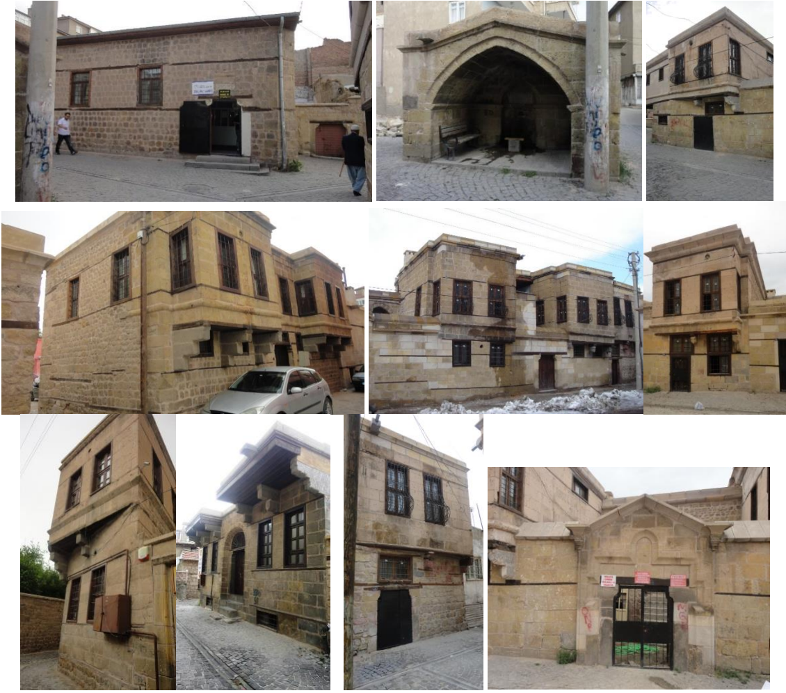
Şekil 5. Cullaz Sokak'taki Cullaz Mescidi, Cullaz Çeşmesi ve sokaktaki geleneksel konutlar sokak sağlıklılaştırma sonrası (Efe Yavaşcan, 2014).
