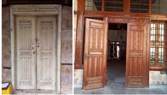
Solda restorasyon çalışmaları öncesi giriş kapısı (Niğde Müze Müdürlüğü, 2012), sağda restorasyon sonrası giriş kapısı (Efe Yavaşcan, 2023)
