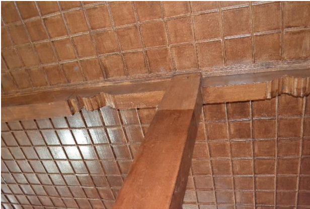
Foto 12. Tavan Alt Kaplaması ve Dikme Yastıkları (Mimar Özlem Durmaz Kaya)
