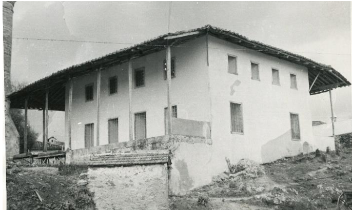
Foto 16. Demircikara Cami Güney-Batı Cephe (VGM Arşivi)
