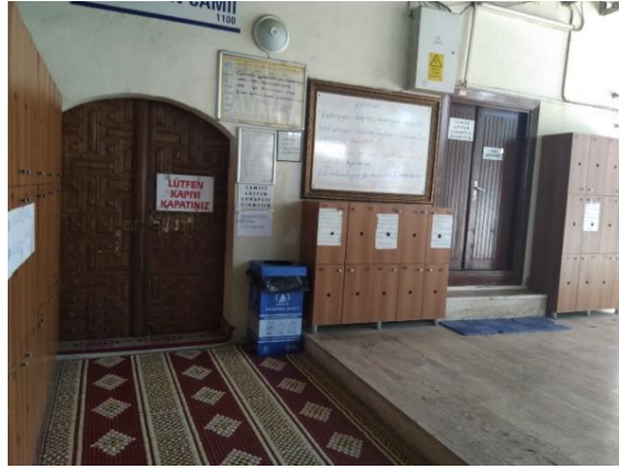
Foto 4. Kuzey Cephe Pencerenin Kapı Olarak Açılması
