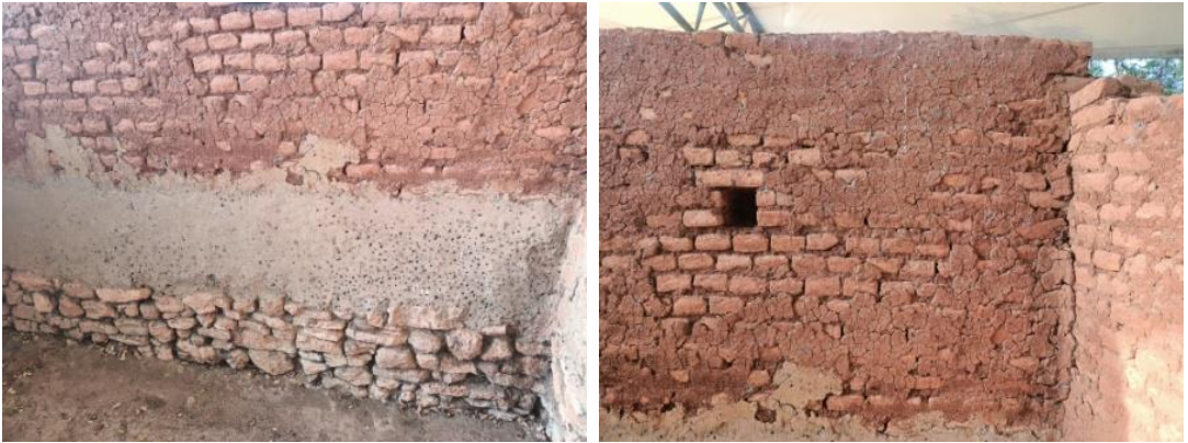
Resim 6: Troya II-III Kale duvarı sıvasında oluşan kırılma ve parçalanma detay görselleri, 2023 (Dikenci, 2024: 63).
