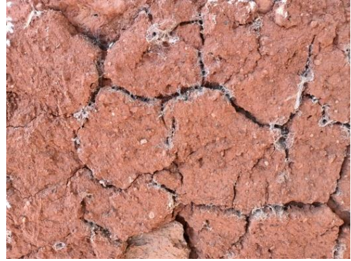
Resim 8: Kerpiç siva ve harcının bozulma detay görselleri, 2023 (Dikenci, 2024: 68).
