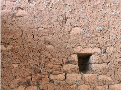
Resim 8: Kerpiç siva ve harcının bozulma detay görselleri, 2023 (Dikenci, 2024: 68).
