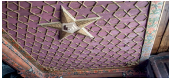
Foto 3: Diyarbakır Ulu Camii Doğu Mahfilinin Ahşap Örtüsü (Url-8)
