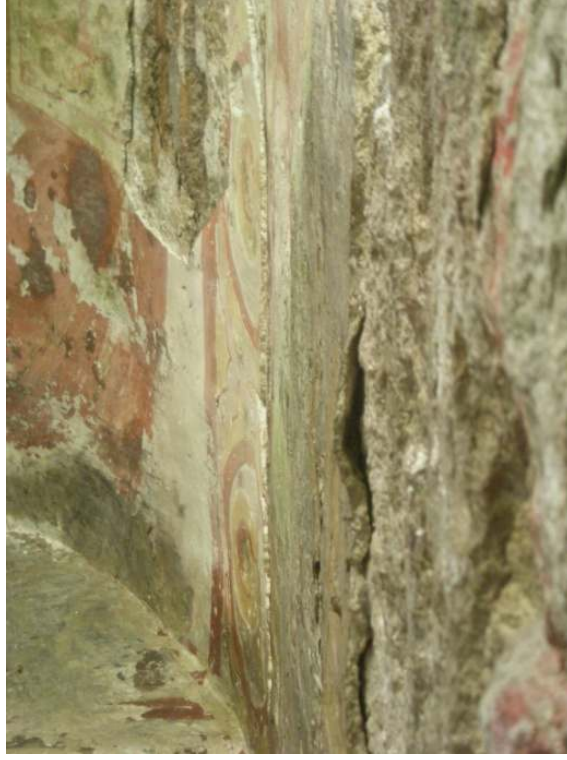
Fig.5 Kaba sıva ile duvar örgüsü arasında yer alan ve enjeksiyon harcı ile acil olarak müdahale edilmesi gereken boşlukların kesitten görünümü. Hande Günözü.
