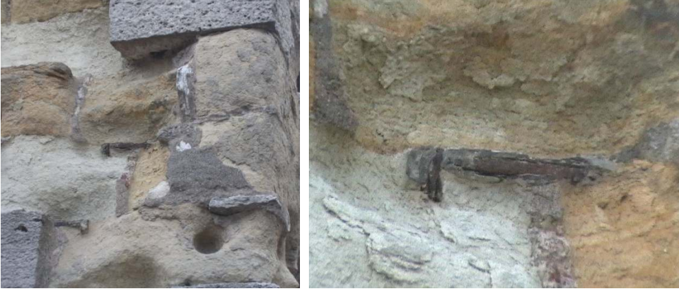
Fig. 3 Dikilitaşın üretiminde statik olarak sağlamlığını sağlamak için kullanılan demir kenetlerin KD cephesinden görünümü (S. Tulgar).
