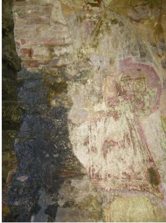
Fig. 2 Su sızıntısının oluşturduğu yüzey erozyonu ve koyu-mavi lacivert renkli akıntı (mikrofilm) tabakası. Hande Günözü.
