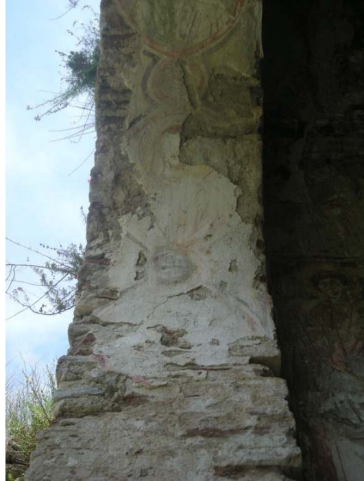
Fig. 10 Gneř iřıđı, hava akımının neden olduđu bozulmalar. Hande Gnz.
