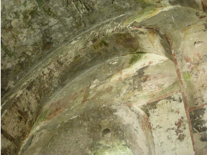
Fig. 6 Kaba sıva ile duvar arasında yer alan boşlukların lokal alanlarda sebep olduğu sıva kayıpları. Hande Günözü.
