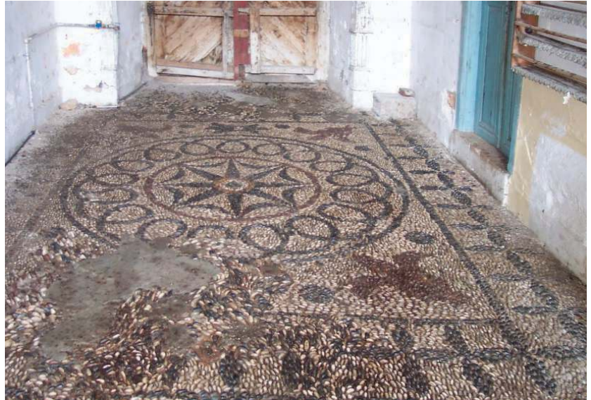
Fig. 11 Sokak kapısı ve taşlığa giriş bölümündeki mozaik uygulamaları.
