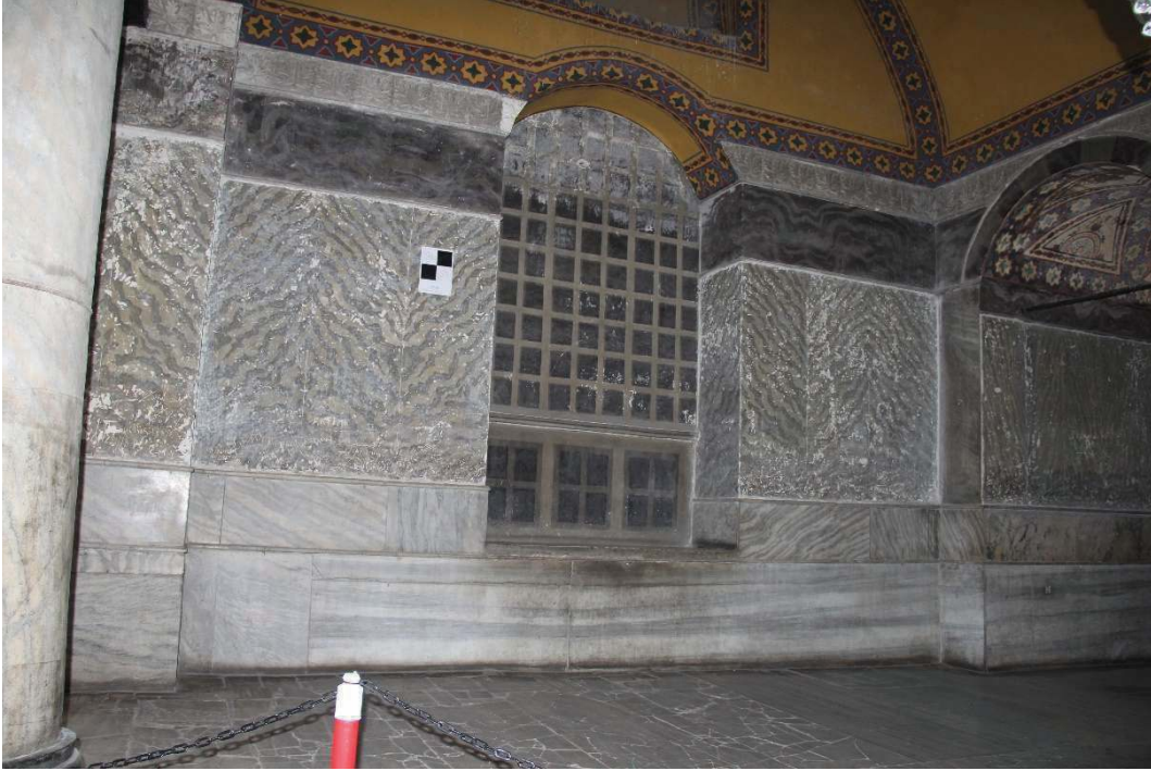
Fig. 10 Kuzey galeri doğu duvarı.
