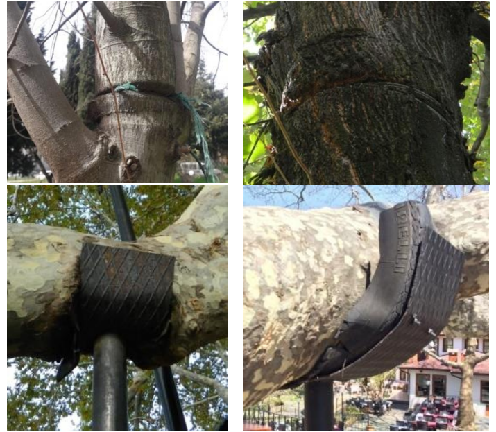
řekil 14. Gövdede ip ve tel bođması ve desteklemelerde büyüme sonucu oluřan deformasyon ve desteklemede tampon kauuk kullanımı
