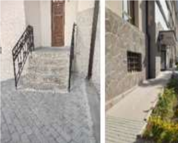
Merdiven ve Küpeşte
