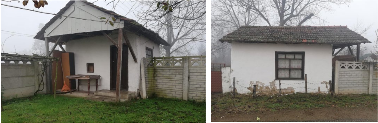
Şekil 37. Haçeş ön cephesi (sol), haçeş sol yan cephesi (sağ).
