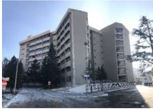
Resim 45. Konya Belediye Binası'ndaki kırma çatıları çevreleyen parapet duvarlar
