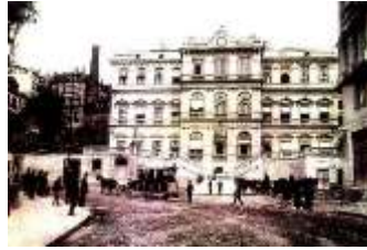
Resim 8. Altıncı Daire-i Belediye Binası (1883) (URL 8)
