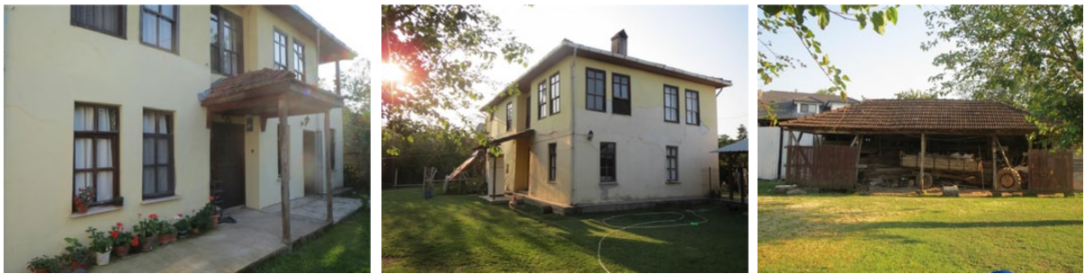
Şekil 24. Önen ana konut giriş cephesi (sol), Önen ana konut sol ve arka cephesi (orta), Önen konut kompleksine ait ardiye (sağ).
