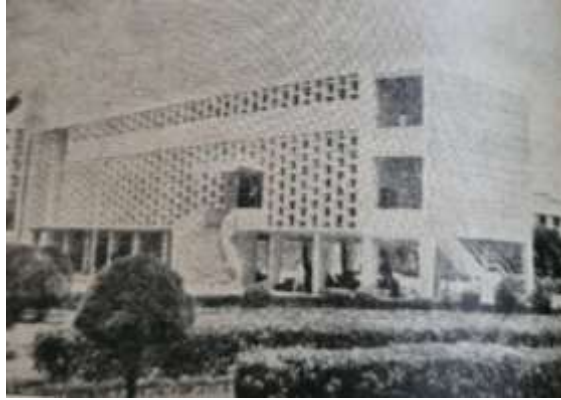
Şekil 8. Sıcak iklimli bölgelerde güneş kırıcı etki sağlamak amacıyla yapılmış cephe sistemi – Akra Merkez Kütüphanesi – Gana (Galvin ve Buren, 1963)
