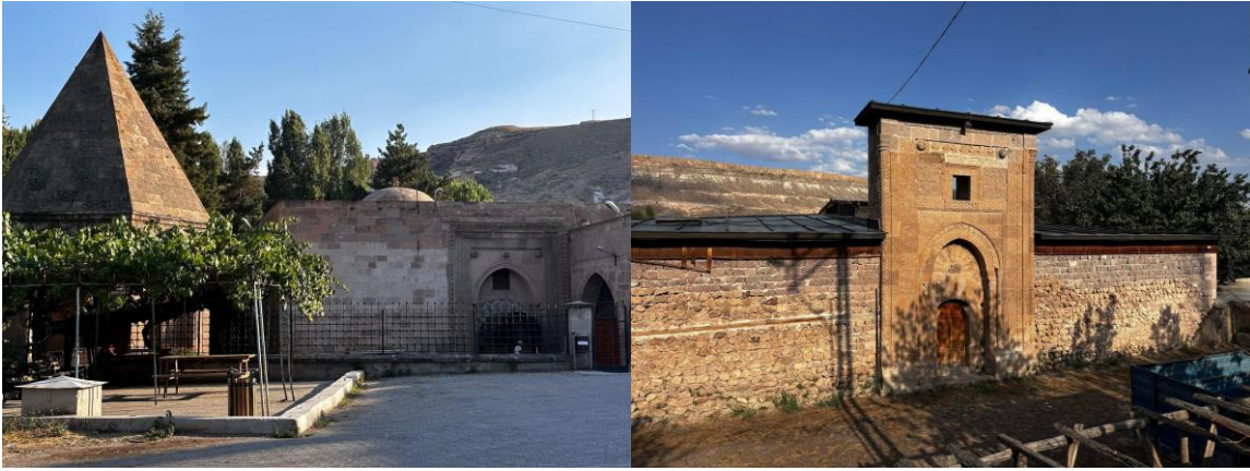
Şekil 10. Taşkınpaşa Cami, Taşkınpaşa Medresesi
