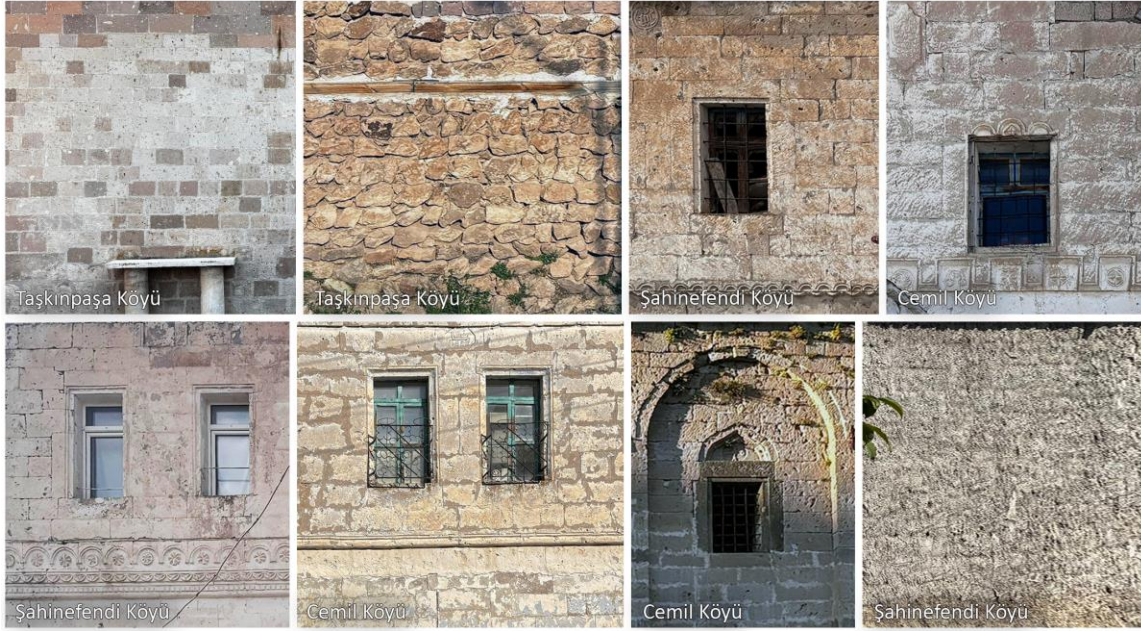
Şekil 15. Taş Duvar Dokularına Örnekler
