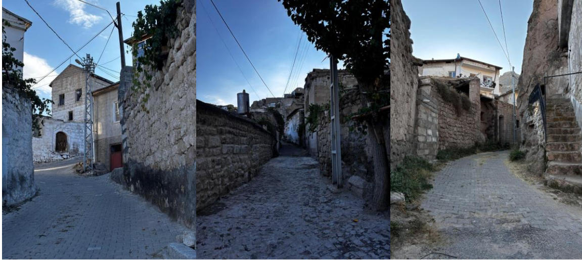
Şekil 8. Cemil Köyünün Kilit Parke Kaplı İç Yolu, Cemil Köyünün Küp Taş Kaplı İç Yolu, Taşkınpaşa Köyü İç Yolu
