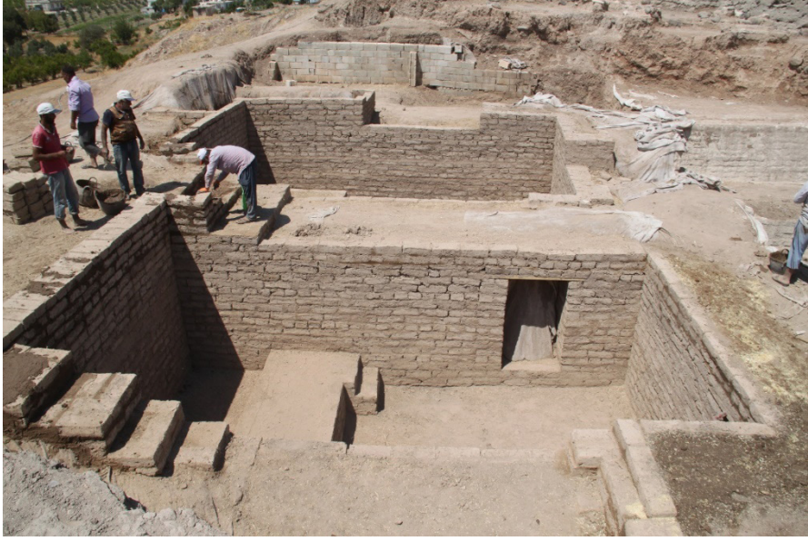
Fig. 17: Saray duvarlarını kerpi mantolama ile koruma alıřmaları
