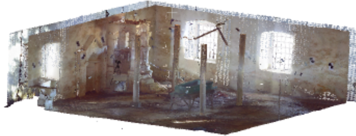
Şekil 4. Nokta bulutu yapının iç mekân görünümü.
