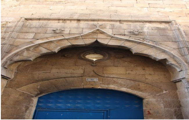
Resim 6: Akyüzler Evi- Kurtuluş Mahallesi Tarakçılar Sokak No.1 ev giriş kapısı
