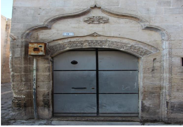
Resim 4: Kurtuluş Mahallesi Hekim Dede Sokak No.19. Ev giriş kapısı
