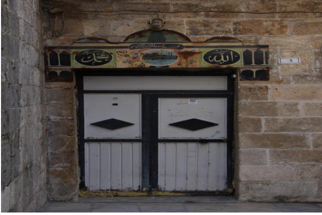
Resim 10: Kurtuluş Mahallesi No.9 ev giriş kapısı
