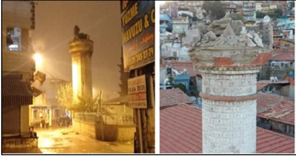
a) Şih Ahmet Minaresi [1] b) Selahattin Oğlu Minaresi [2] Şekil 1. Depremde hasar gören minareler.
