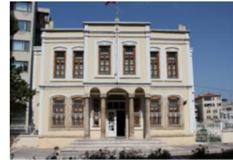
Foto. 26. Kırklareli Belediye Binası (1900 öncesi) 92
