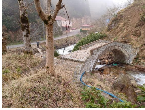
Foto. 27. Tarihi Agrid (Çamliyurt II) Köprüsü Batı Cephe Görünüm (2024)
