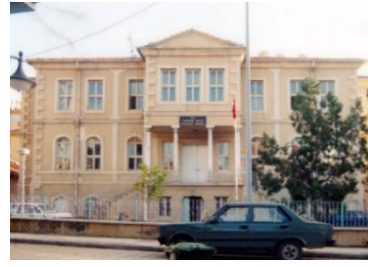
Foto. 28. Taşköprü Hükümet Konağı (1892-1893) 94
