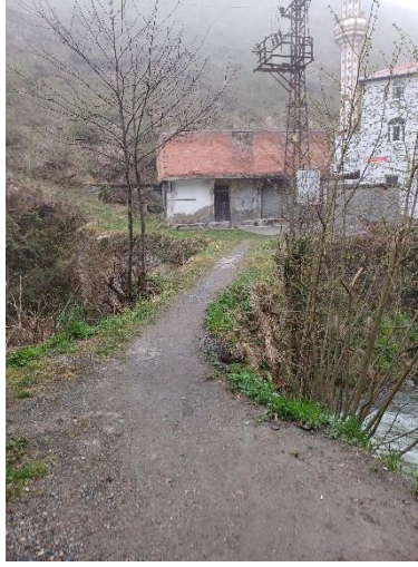
Foto. 40. Goballı Köprüsü Tabliye Görünüm (Y. Sarı, 2024)
