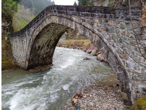
Foto. 18. Kaşıkçı Köprüsü Malzeme Detayı (2024)
