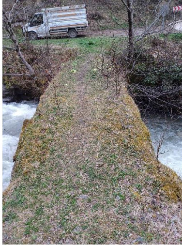
Foto. 34. Agrit Köprüsü Tabliye Genel Görünüm (2024)
