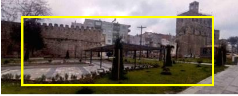
Foto. 47. Günümüzde Belediye Binası'nın Oturum Alanı (Şubat 2023) 142
