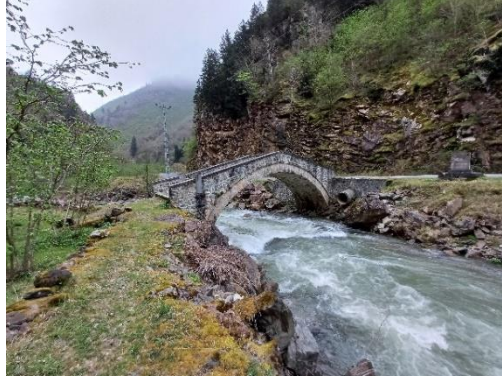
Foto. 9. Sincan Köprüsü Kuzey Cephe Görünüm (2024)
