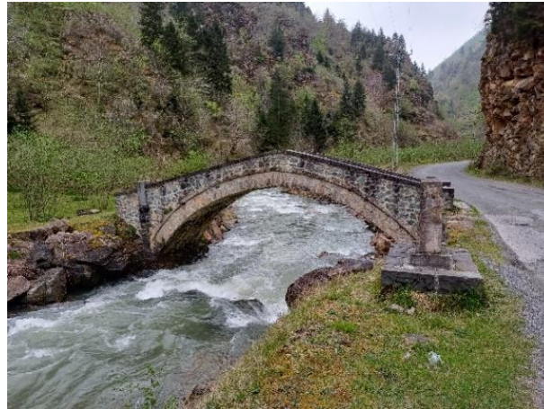
Foto. 10. Sincan Köprüsü Güney Cephe Görünüm (2024)
