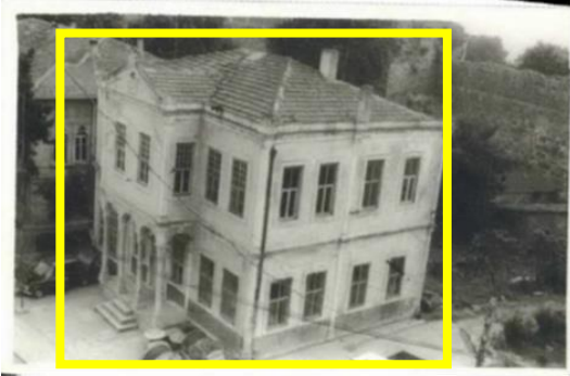
Foto. 12. Sinop Eski Kâğır Binası (1975)
