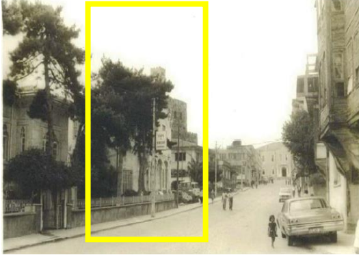
Foto. 10. Sinop Eski Kâğır Binası (1975)
