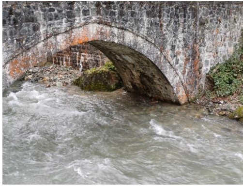
Foto. 25. Tandırlı Köprüsü Ayak Detayı (Y. Sarı, 2024)
