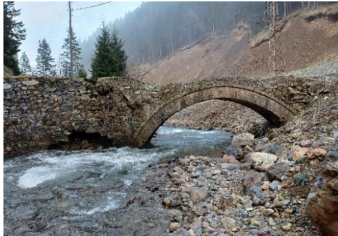
Foto. 44. Yamakoğun (Ayeni) Köprüsü Güney Cephe Görünüm (2024)
