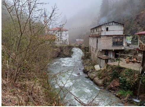
Foto. 37. Goballı Köprüsü Güney Cephe Görünüm (2024)
