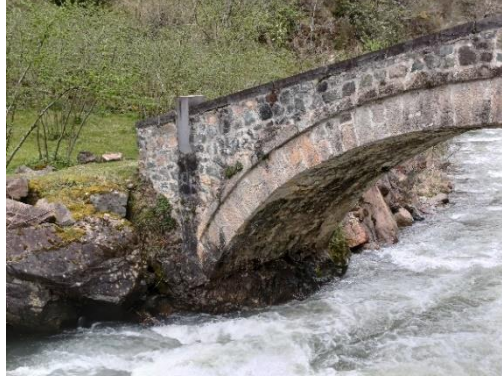
Foto. 12. Sincan Köprüsü Malzeme Detayı (2024)
