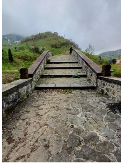
Foto. 5. Yeniköy Köprüsü Tabliye Görünüm (2024)
