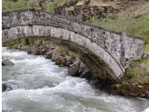
Foto. 13. Sincan Köprüsü Ayak Detayı (2024)
