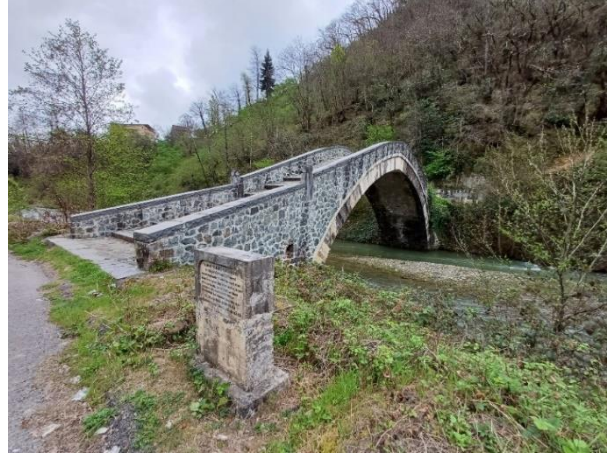
Foto. 2. Yeniköy Köprüsü Güney Cephe Görünüm (2024)
