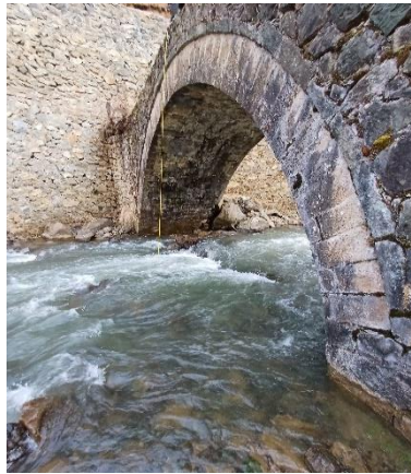
Foto. 50. Binatlı (Terzili, Cingalli) Köprüsü Ayak Detayı (2024)
