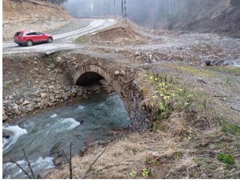
Foto. 45. Yamakoğun (Ayeni) Köprüsü Tabliye Görünüm (2024)
