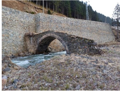
Foto. 49. Binatlı (Terzili, Cingalli) Köprüsü Kemer Detayı (2024)
