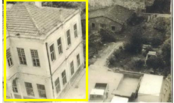
Foto. 13. Sinop Eski Kâğır Binası (1975)
