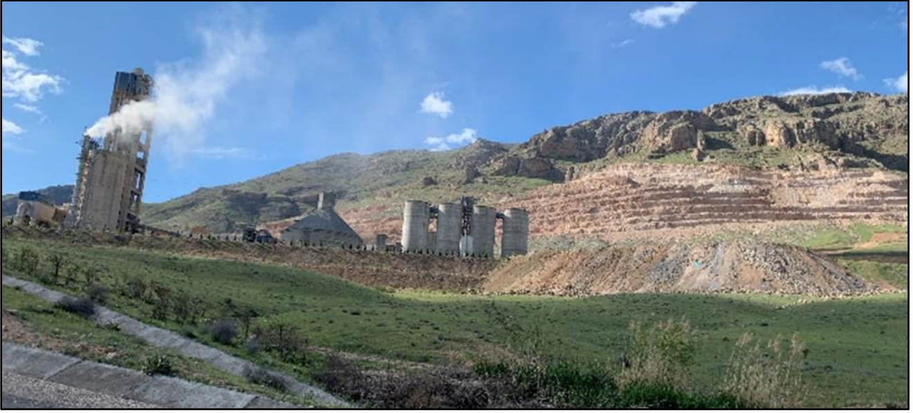
Şekil 11. Karakaya Baraj Gölü kıyısında (Pınarlı Köyü) yer alan çimento fabrikası (Fotoğraf: Murat AYDIN, 29.04.2023).
