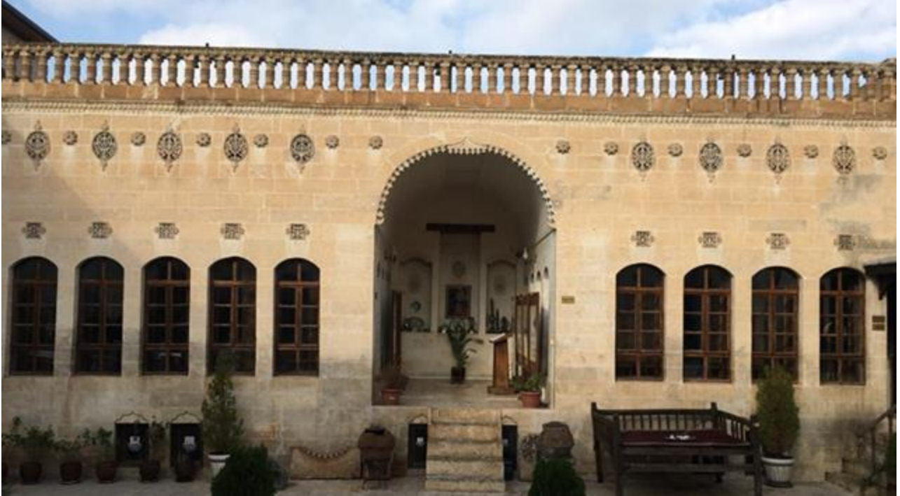
Şekil 14: Kesme taş duvar örneği (Şanlıurfa Mutfak Müzesi-Hacıbanlar Evi)
