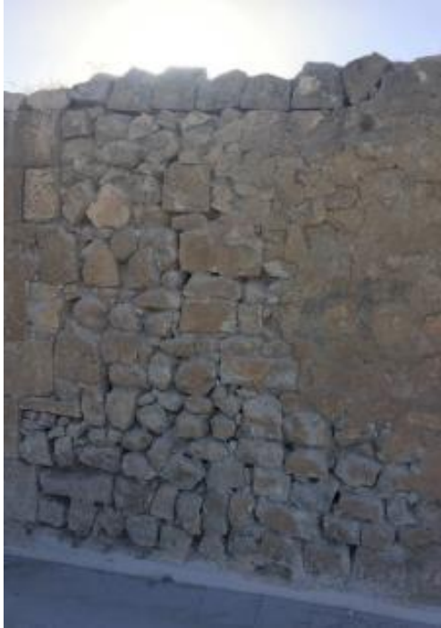
Şekil 11: Moloz taş duvar örneği
