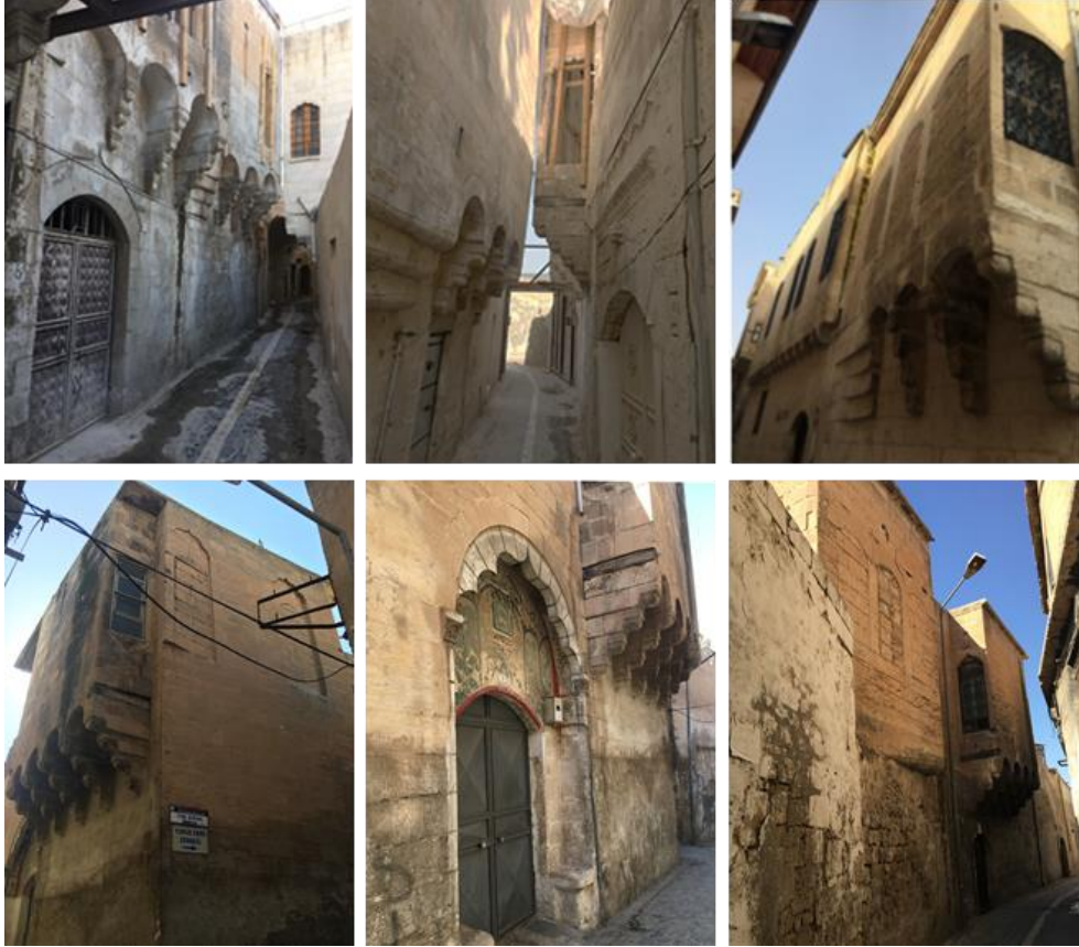
Şekil 17: Çıkma duvarları (Cumbalar) ve bingi taşları
