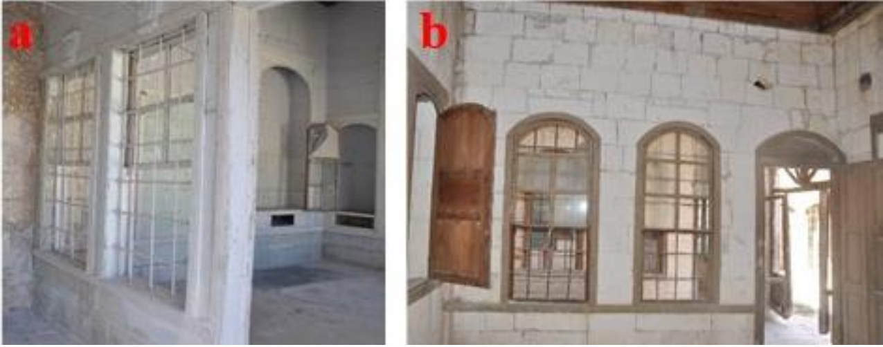
Şekil 6: a. b. İç mekânlarda kullanılan "tek cidarlı duvar" örnekleri
