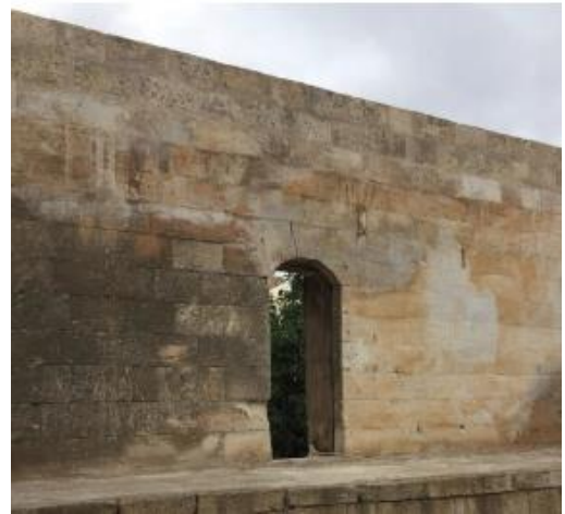
Şekil 13: İnce yonu taş duvar örneği
