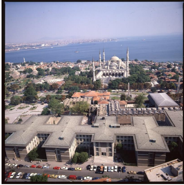
Şekil 13: Adliye Sarayı'nın günümüzdeki durumu (Kültür Envanteri, Eski Sultanahmet Adliye Binası).
