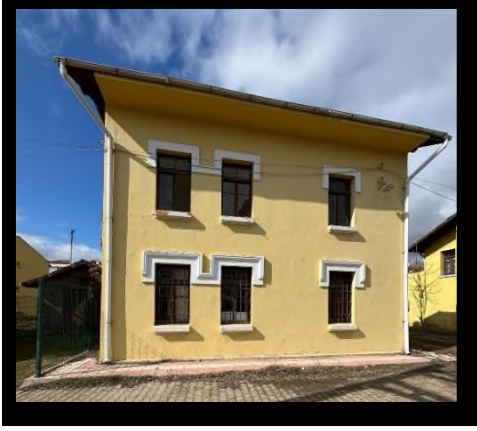
Şekil 16. Lojman I Doğu Cephe.
