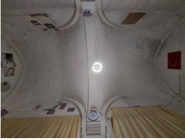
c- Çapraz Tonozlu Tavan Sistemi
