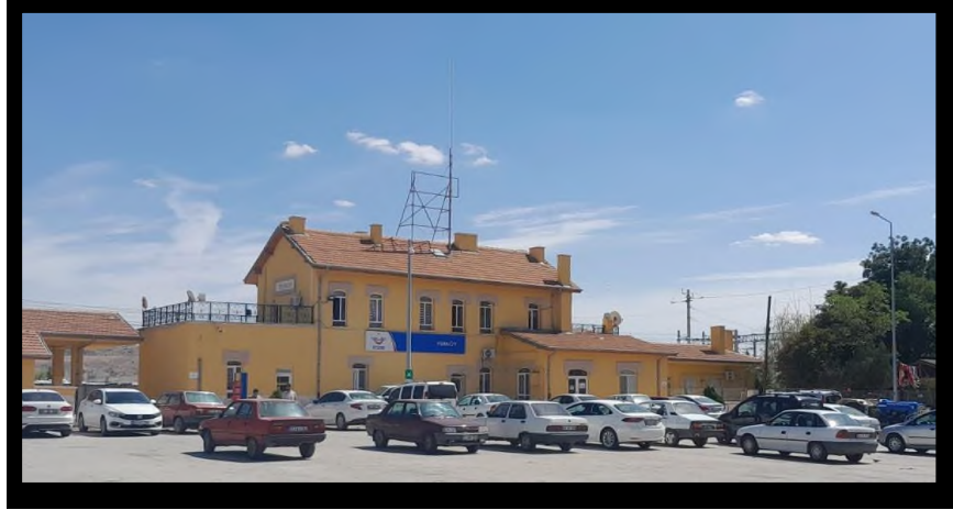
Şekil 12. Yerköy İstasyonu Yolcu Binası (batı) Meydan Cephesi, 2022.
