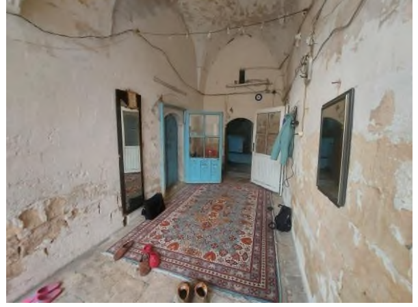
b- Zemin Kat Eyvanının İçi ve Oda Bağlantıları
