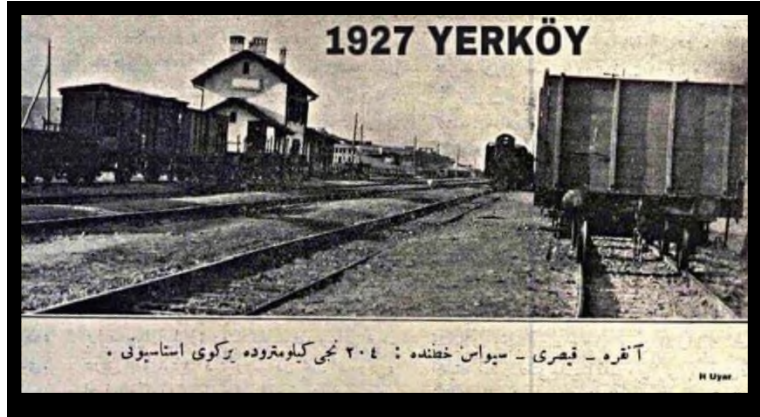
Şekil 10. Ankara-Kayseri-Sivas hattında: 204. kilometrede Yerköy istasyonu. (H. Uyar arşivi)
