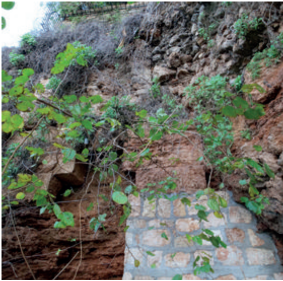
FIG. 22 Attaleia. Ashlar masonry of sea-cliff face of Keçili Parkı / Yanık Hastane.
