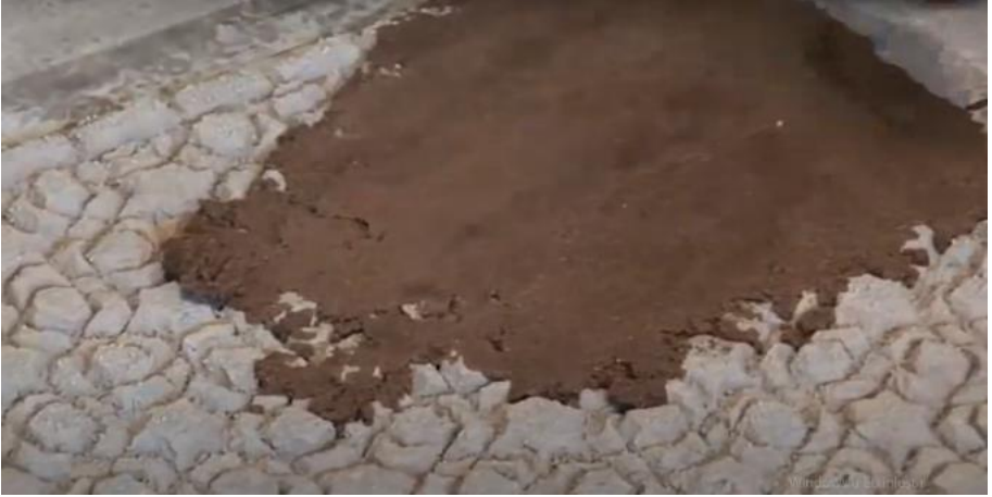
Şekil 21: Parçaların birbirini iyi tutması ve kolay taşınması için yapıştırıcı harcın yüzeye uygulanması. 93
