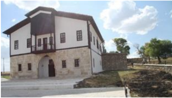
Fotoğraf 5. Konađın onarım sonrası doğu cephesi (Fotoğraf, 2015), İl Özel İdaresi İmar Bölümü.
