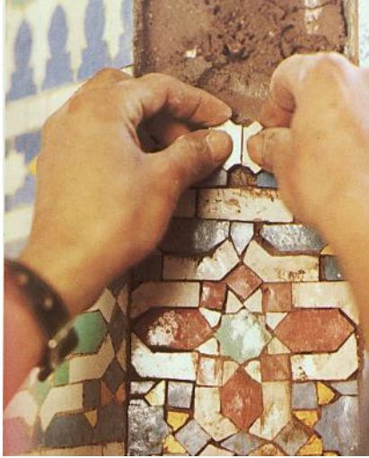
Şekil 23: Zellic parçalarının direkt duvar yüzeyine uygulanması 96
