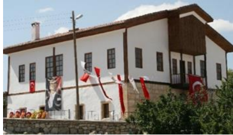
Fotoğraf 2. Mihrali Bey Konağı onarım sonrası (Fotoğraf, 2006), İl Özel İdaresi İmar Bölümü.
