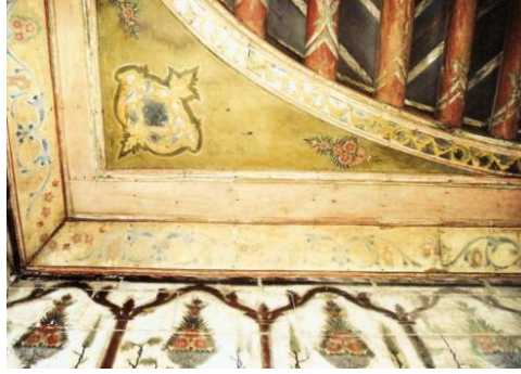
Şekil 24. Ahşap Dikmelerin Kısımları Olarak Kapatıldığı Tavan, Melek Dal, 2019.
