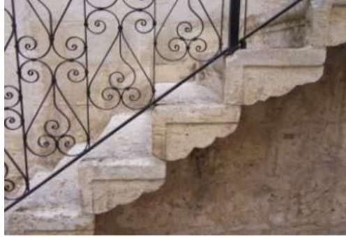
Şekil 17. Keymiş Taşlı Merdiven Örneği, Kaleoğlu Kanalcı, 2010.
