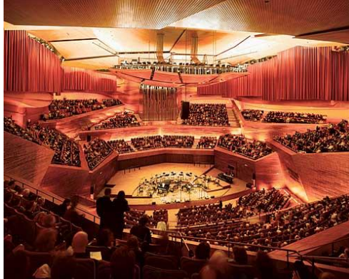
Şekil 20. Ana konser salonundaki duvar perdeleri ve kanopi (URL25 (Roland Halbe)).
