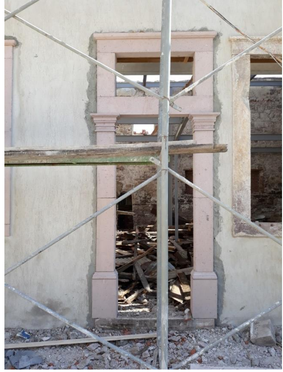
Şekil 24. Tariş Zeytinyağı Fabrikası - Restorasyon Şantiyesi Resimleri (Aytaç 2019).
