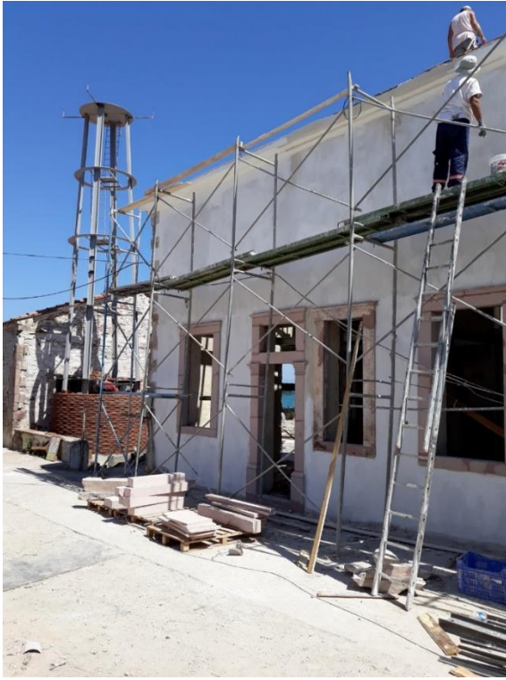
Şekil 25. Tariş Zeytinyağı Fabrikası - Restorasyon Şantiyesi Resimleri (Aytaç 2019).
