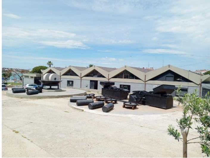
Şekil 14. Vakıflar Zeytinyağı Fabrikası-Ayvalık Zeytin Müzesi yan cephesi, üçgen alınlıklar ve dış avluda sergilenen ekipmanlar (Aytaç 2024).
