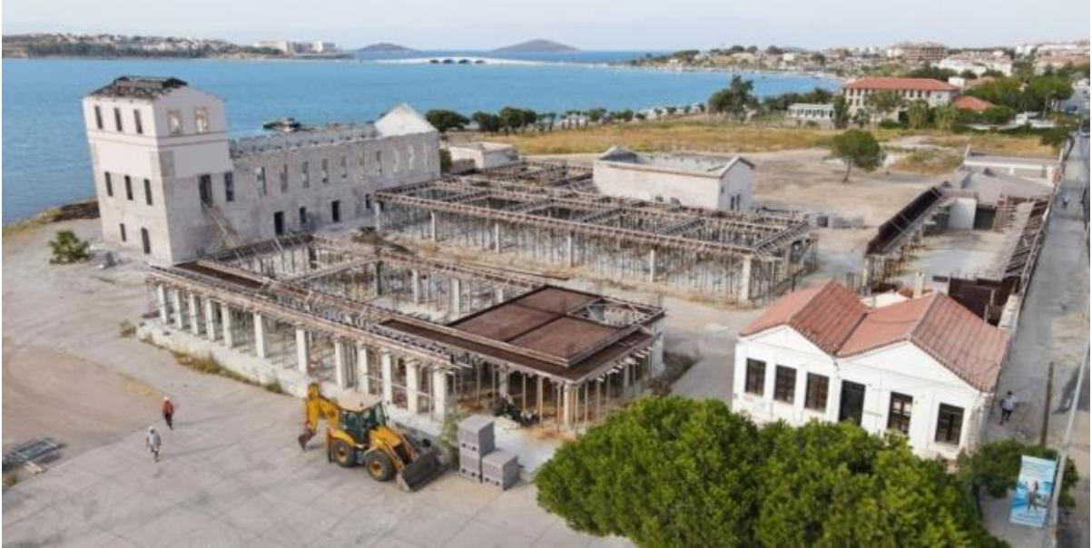
Şekil 20. Kırilangıç Zeytinyağı Fabrikası restorasyon projesi inşaat aşamasından görüntü (Tokyay, 2022).
