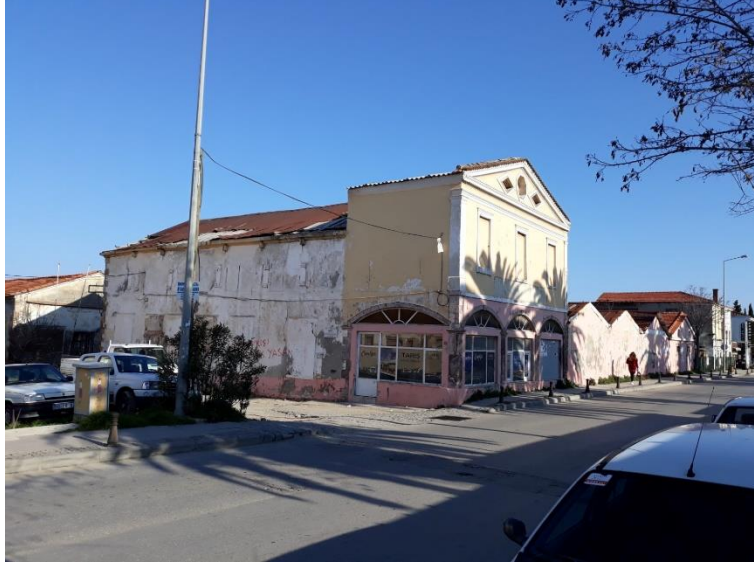
Şekil 21. Tariş Zeytinyağı Fabrikası - restorasyon şantiyesi resimleri (Aytaç 2019).
