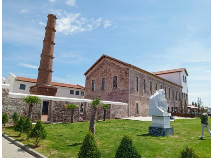
Şekil 18. Kırilangıç Zeytinyağı Fabrikası ana bina ve baca (Aytaç 2024).
