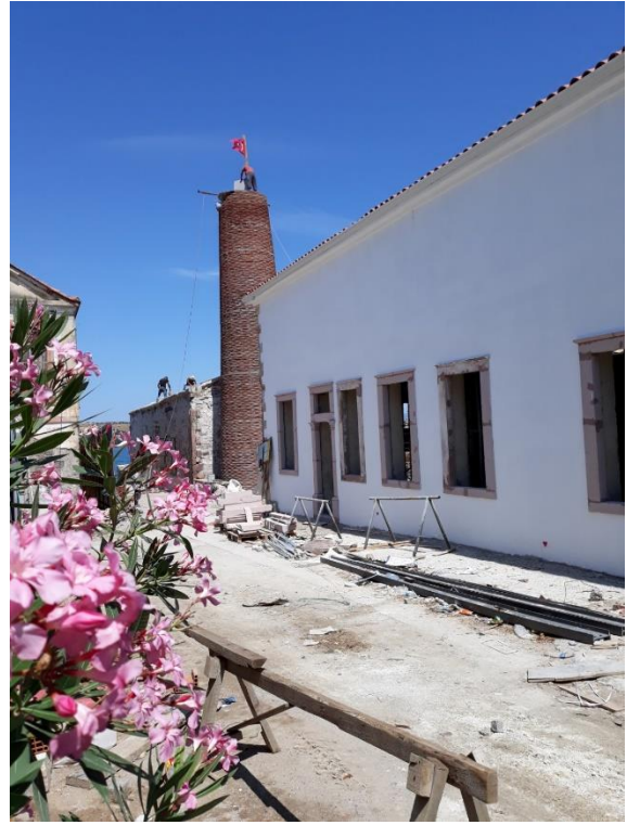
Şekil 26. Tariş Zeytinyağı Fabrikası - Restorasyon Şantiyesi Resimleri (Aytaç 2019).
