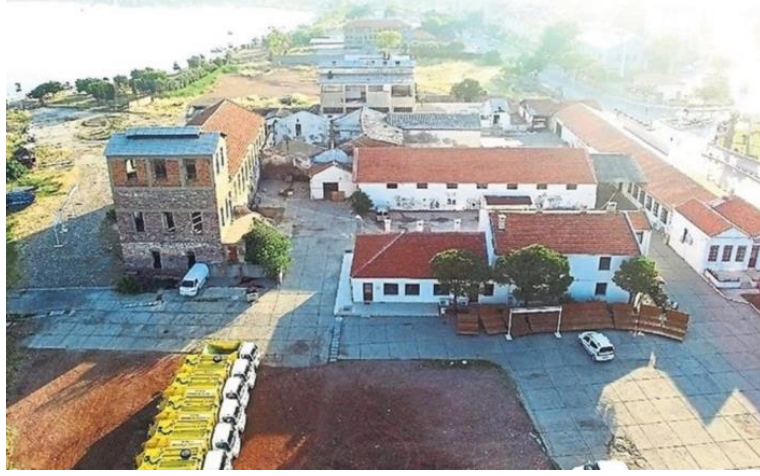
Şekil 19. Kırilangıç Zeytinyağı Fabrikası restorasyon projesi inşaat aşaması öncesi görüntü (Tokyay, 2022).
