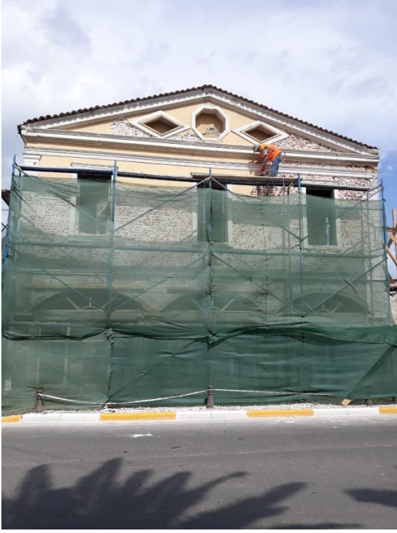
Şekil 23. Tariş Zeytinyağı Fabrikası - Restorasyon Şantiyesi Resimleri (Aytaç 2019).
