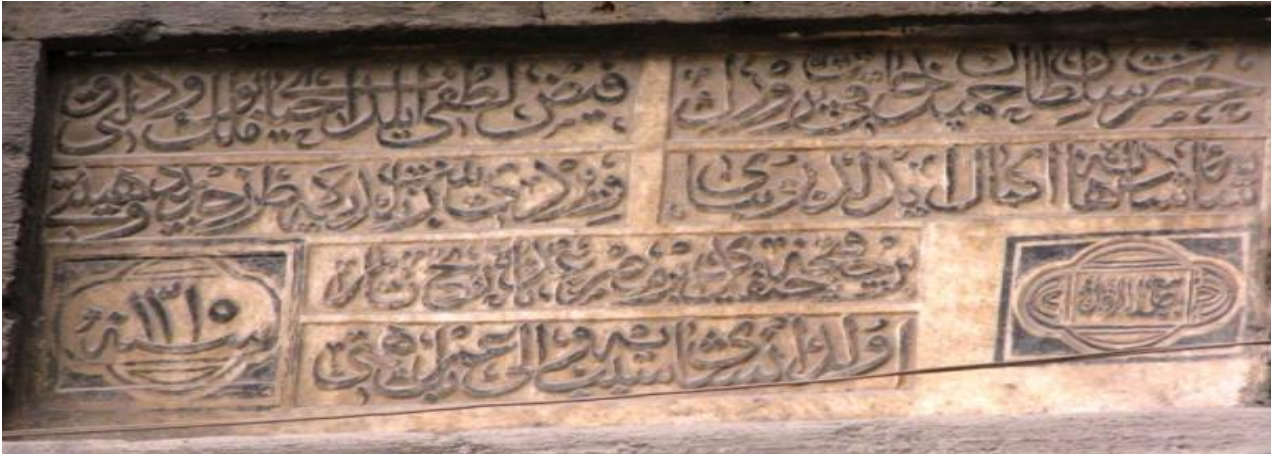
Şekil 7. Bitlis Eski Belediye Binası kitabe görünüşü (Kaynak: Çalışma kapsamında yazar tarafından oluşturulmuştur, 2012).
