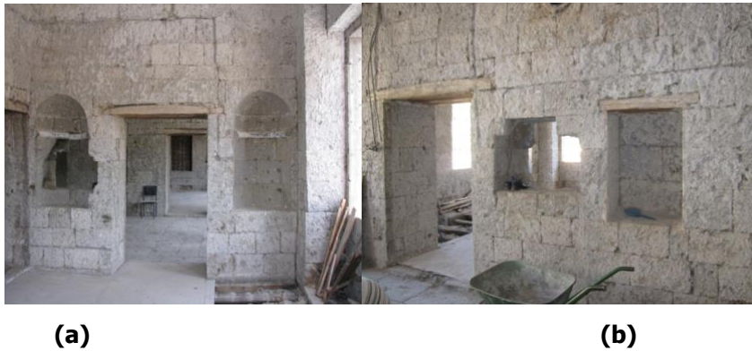
Şekil 33. Bitlis Eski Belediye Binası (a, b) Zemin kat iç mekân görünüşleri (Kaynak: (a, b) Çalışma kapsamında yazar tarafından oluşturulmuştur, 2012).
