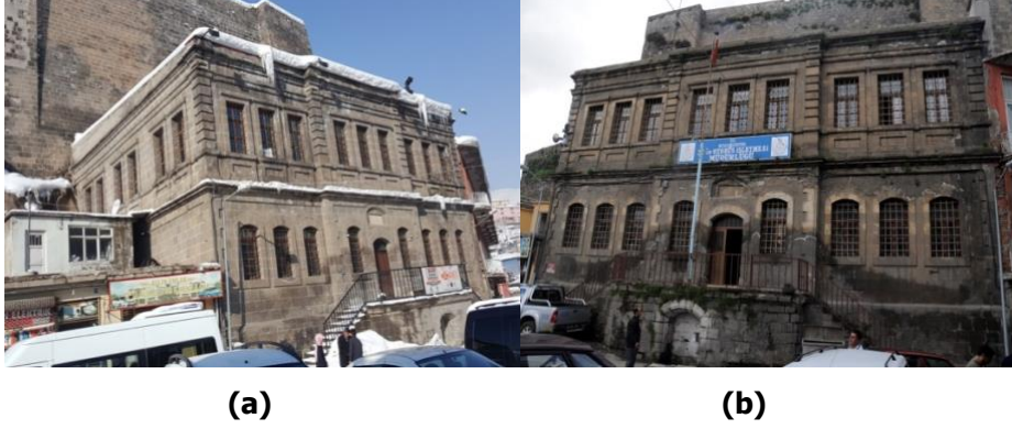
Şekil 6. (a, b) Bitlis Eski Belediye Binası genel görünüşleri (Kaynak: Çalışma kapsamında yazar tarafından oluşturulmuştur, 2022).
