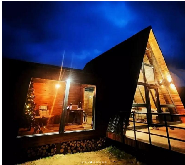
Şekil 6. Ön cephe (yazar arşivinden).
