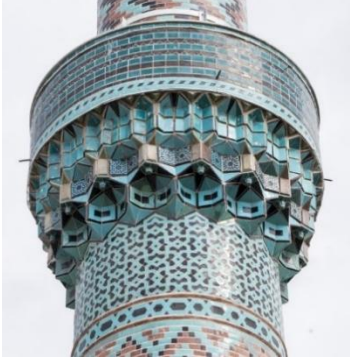
Görsel 4: İznik Yeşil Camii Minaresi ( http-2 )
