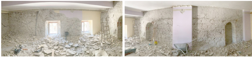
Görsel 16. Kelime Müzesi'nin restorasyon çalışmalarından, Ankara Kelime Müzesi Arşivi
