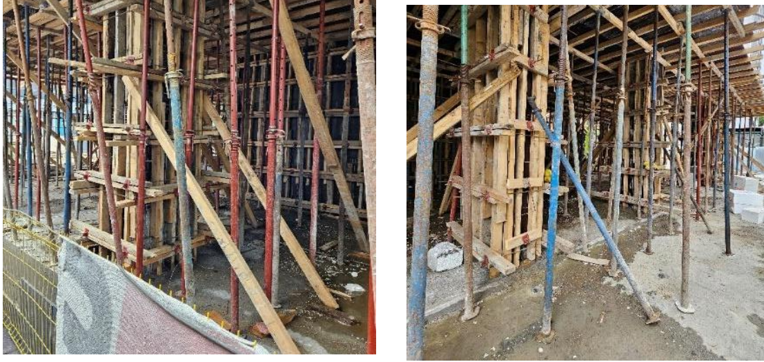
Şekil 4: Destek payanda (ahşap/metal) (Yazar tarafından üretilmiştir, 2024)
