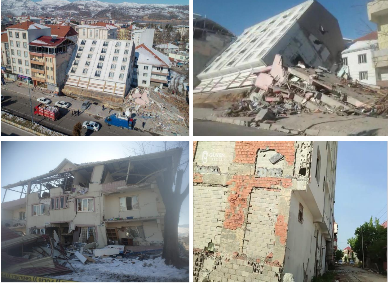
Şekil 1: 6 Şubat 2023 Kahramanmaraş-Pazarcık depreminde sıvılaşma sonucu hasar almış binalar.
