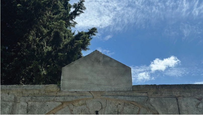
Şekil 32: Takkeci İbrahim Ağa Camii’nin Sultan II. Mahmud devrine ait onarım kitabesi
