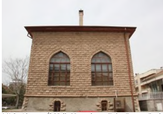
Şekil 9. Aksaray İl Halk Kütüphanesi'nin Güney Cephesi.
