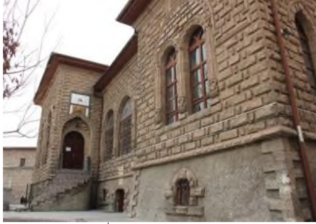
Şekil 11. Aksaray İl Halk Kütüphanesi'nin Doğu Cephesi.
