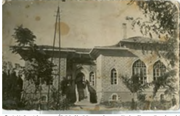
Şekil 2. Aksaray İl Halk Kütüphanesi'nin Batı Cephesi 6 .
