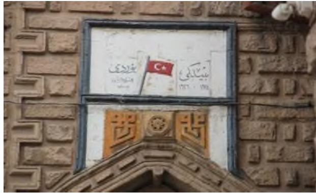
Şekil 10. Aksaray İl Halk Kütüphanesi'nin Doğu Cephesindeki Giriş Açıklığının Üzerindeki Kitabe.
