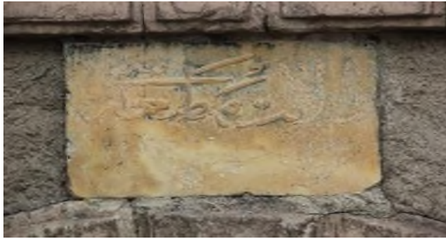
Şekil 12. Yapının Doğu Cephesindeki Bodrum Katın Giriş Kapısı Üzerinde Bulunan Matbaanın Kitabesi.
