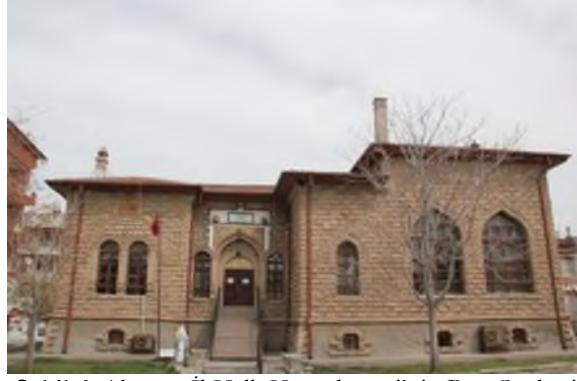
Şekil 6. Aksaray İl Halk Kütüphanesi'nin Batı Cephesi.
