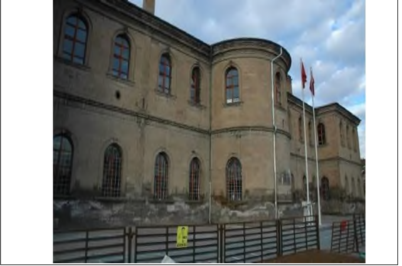
Fotoğraf 5. Yapının Güney Cephesinden Genel Görünüşü (Sağirođlu Arslan, 2014, s.26)
