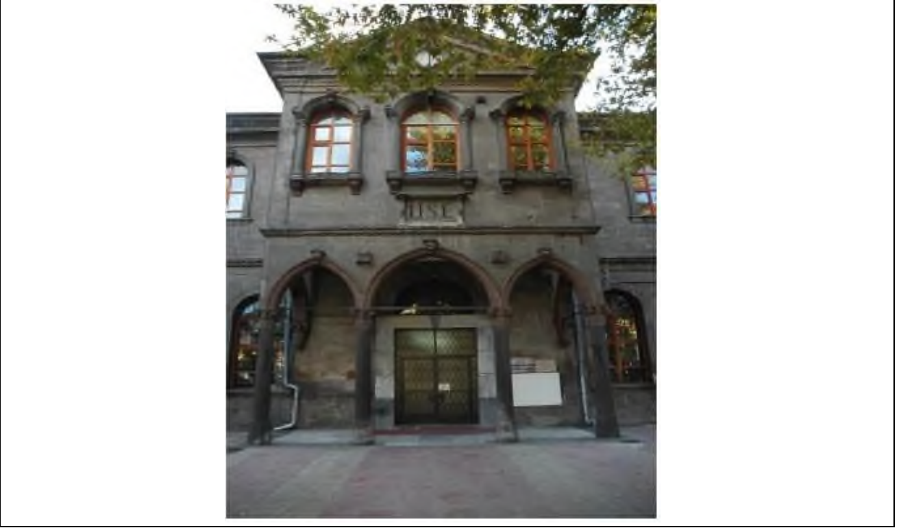
Fotoğraf 1. Yapının Kuzey Cephesindeki Ana Giriş Kapısı (Sağiroğlu Arslan, 2014, s. 28)
