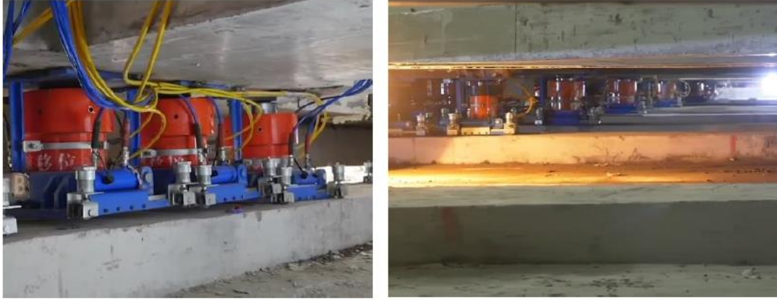
Şekil 10-11: Destekleme Kirişlerinin Altındaki Hidrolik Krikolar(Arpacık,2022)
