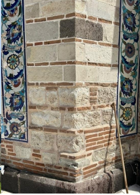
Şekil 3: Yalı Duvar ve Derz Örgüsü (Kaynak: Kişisel Arşiv).
