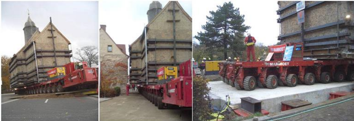
Şekil 12:SPMT Araçları ile Taşıma (Koitzsch,2008)
