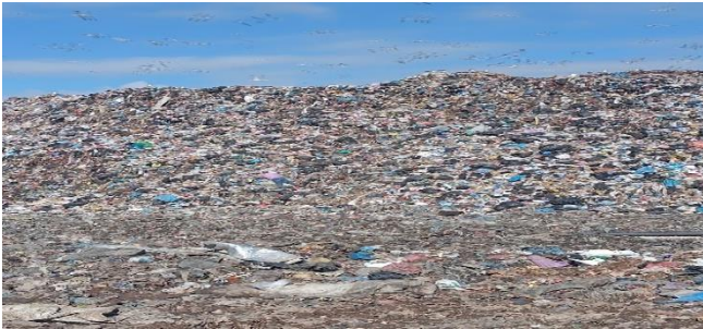
Şekil 4 Diyarbakır biyogaz tesisinde depolanan atıklar
