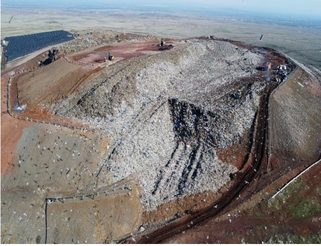
Şekil 12 Atık biriktirme alanı
