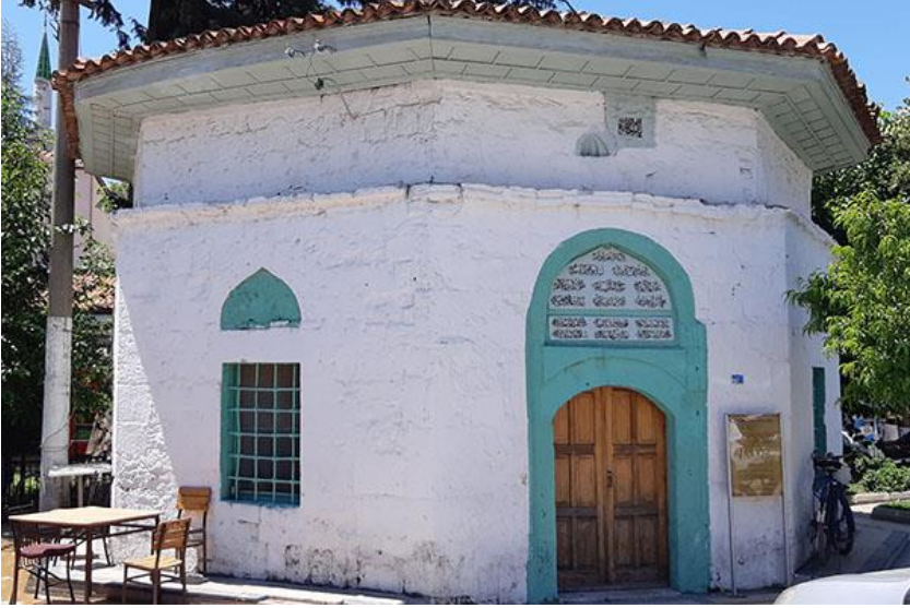
Türbenin dıştan görünüşü
