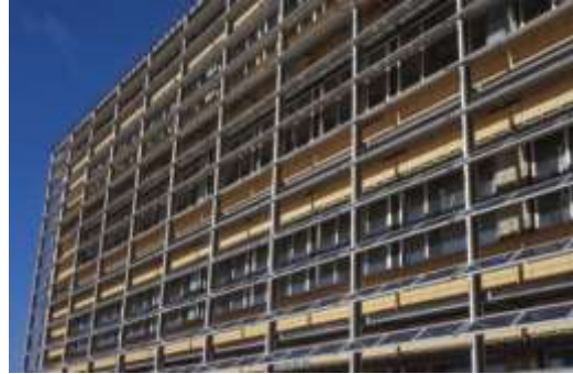
Şekil 8. ECN31 binası cephede kullanılan fotovoltaik paneller (URL-3).
