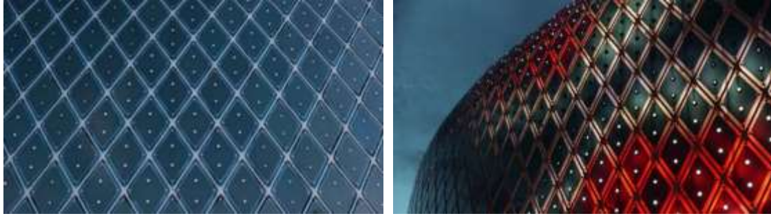
Şekil 31. Novartis Pavyonu cephede kullanılan organik fotovoltaiik modüller (URL-17).
