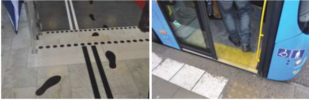
Şekil 1. Baros Belediye Kültür Merkezi Binası içerisinde yer alan hissedilebilir yüzey uygulaması (solda) araç yolu ile aynı kotta yer alan kaldırımlar (sağda) (Elmacı, 2019, s. 41-43).
