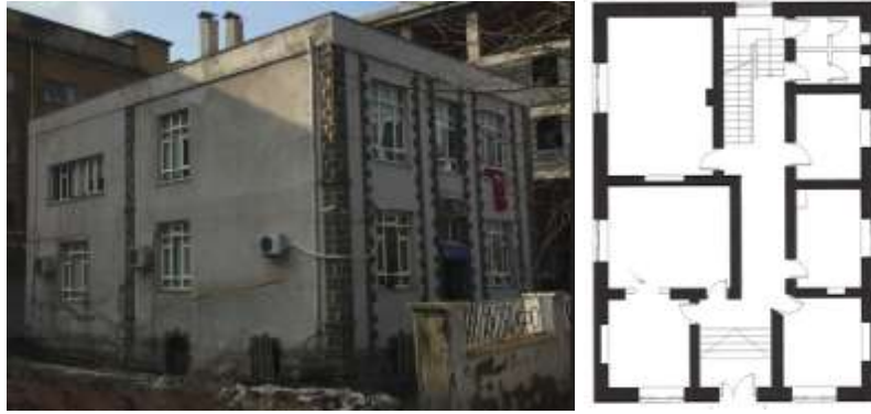
Şekil 6. Diyarbakır Eski Nafiye Binası (Dalkılıç, 2011; Dağtekin, 2023).
