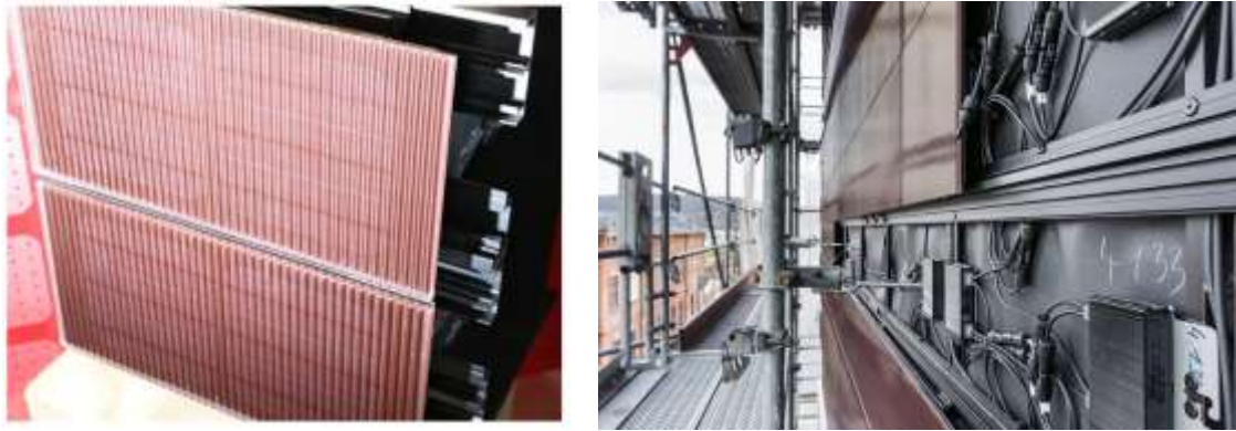
Şekil 17. Modülde yer alan dokulu renkli cam (solda) ve panel duvar montajı (URL-7).
